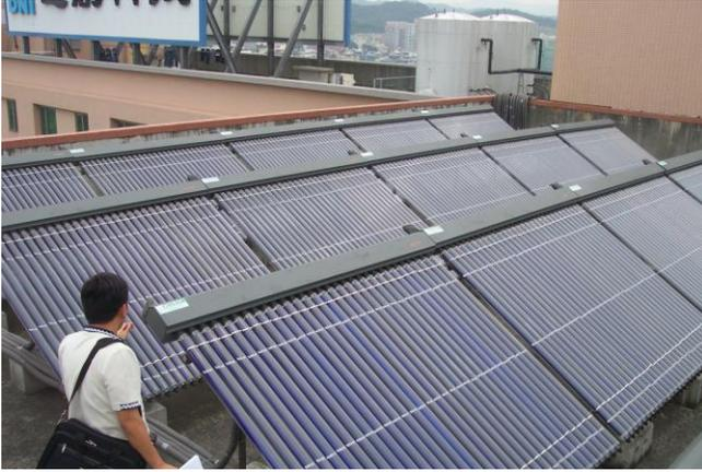
Fig. 4: SWH-Vacuum-Tube Type
