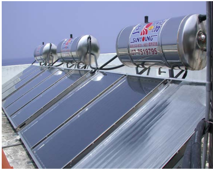
圖一、平板式太陽能集熱器
