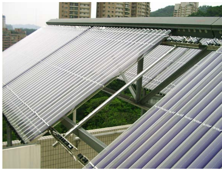
圖二、真空管式太陽能集熱器
